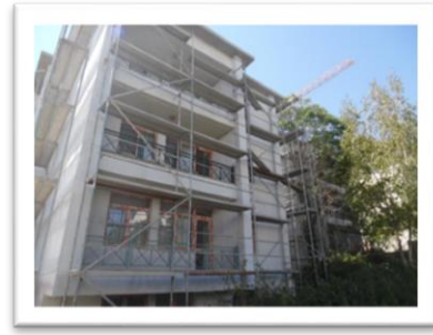
Resim.2.6.1.a. 17.lojman Binası için Yapılan Isı Yalıtımı Uygulaması
