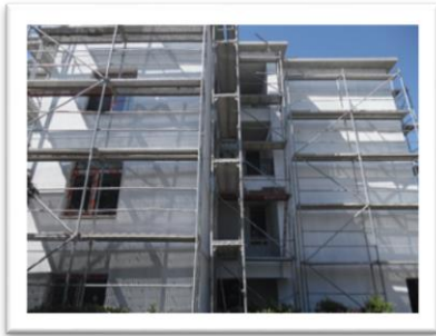
Resim.2.6.1.a. 17.lojman Binası için Yapılan Isı Yalıtımı Uygulaması
