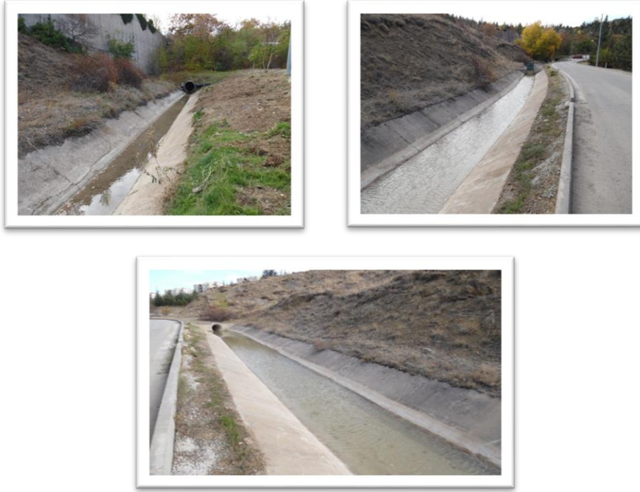
Resim.4.2.a. Su Geri Dönüşüm Programı Kapsamında Yağmur Kanalları
