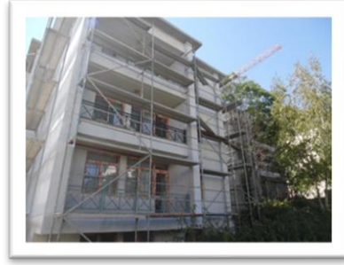
Resim.2.6.1.a. 17.lojman Binası için Yapılan Isı Yalıtımı Uygulaması
