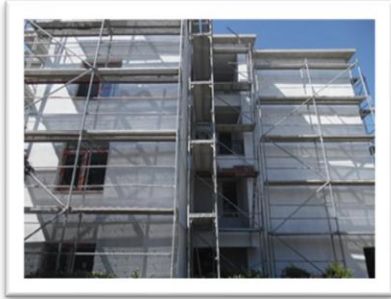
Resim.2.6.1.a. 17.lojman Binası için Yapılan Isı Yalıtımı Uygulaması
