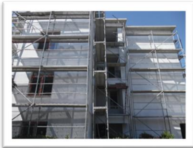
Resim.2.5.1.a. 17.lojman Binası için Yapılan Isı Yalıtımı Uygulaması
