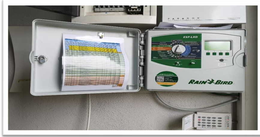
Resim.2.2.j. Sulama Otomasyon Sistemi
